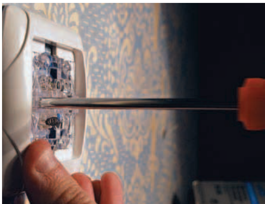
> Завинчиваем распорные винты
