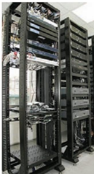
**Рис. 2.** Типичная стойка без охлаждения
